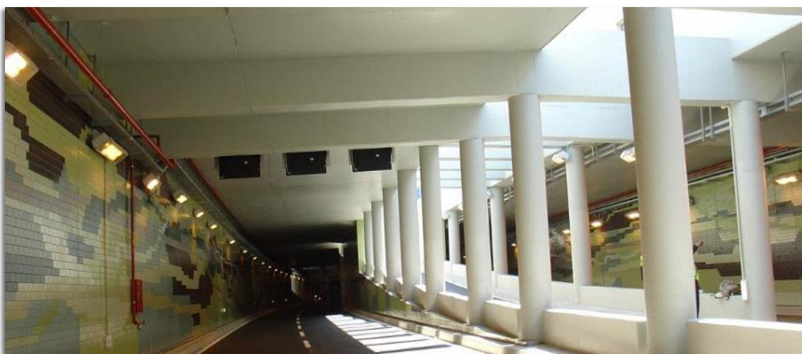
FIGURA 3-18 TÚNEL DO MARQUÊS DE POMBAL
