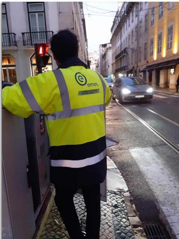
FIGURA 3-12 COLABORADOR DA EMEL NA OPERAÇÃO DA SLAT
