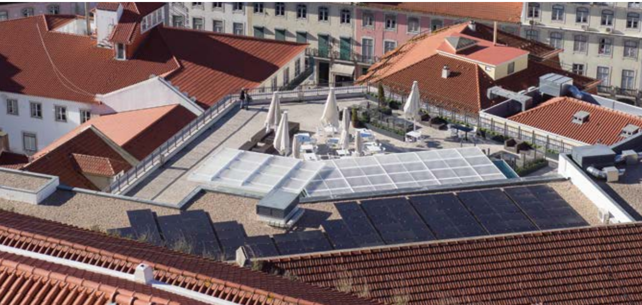
Topo do Mercado Chão do Loureiro (Painéis fotovoltaicos)
